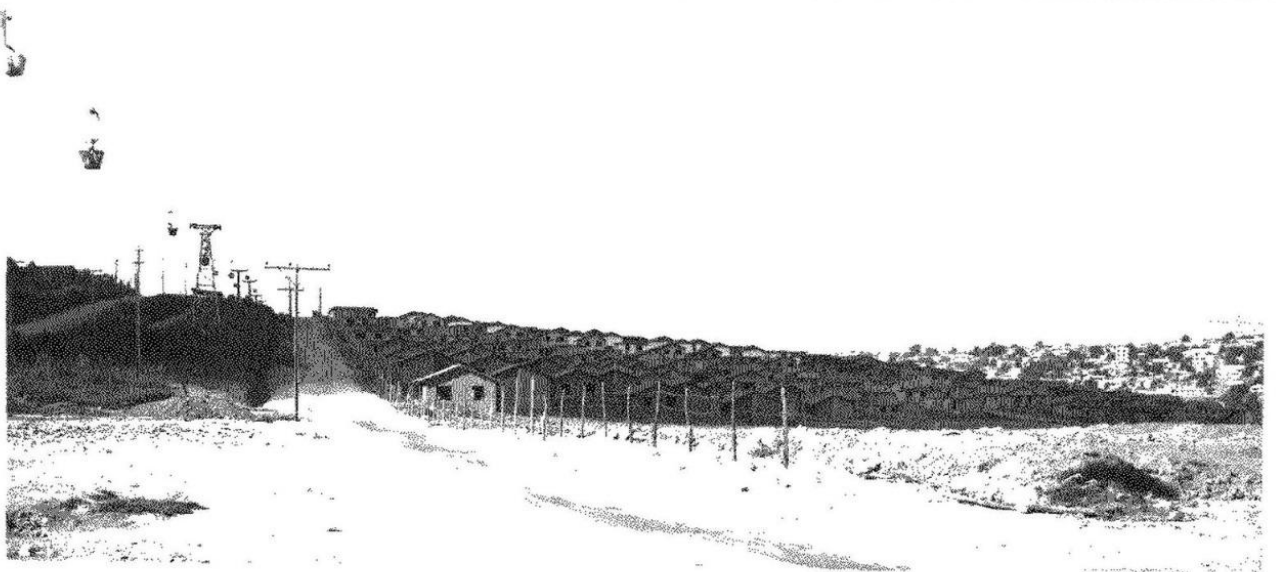
Foto 1 - Conjunto Água Branca, em construção
